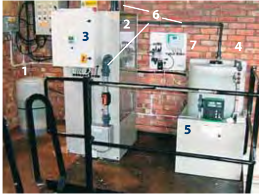
Рис. 91. Система получения раствора гипохлорита натрия Selcorperm 195-125.
