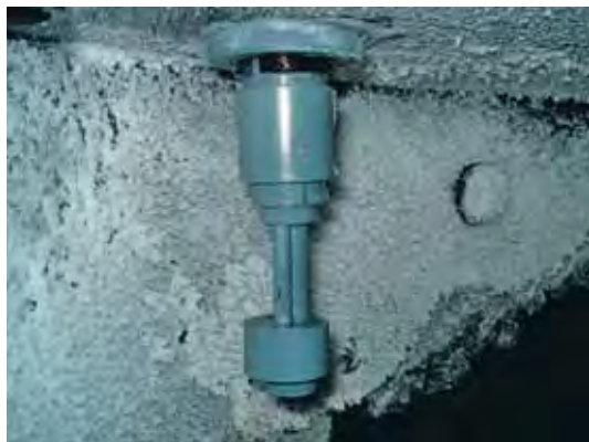
Рис. 86. Образование высолов в сатураторе
