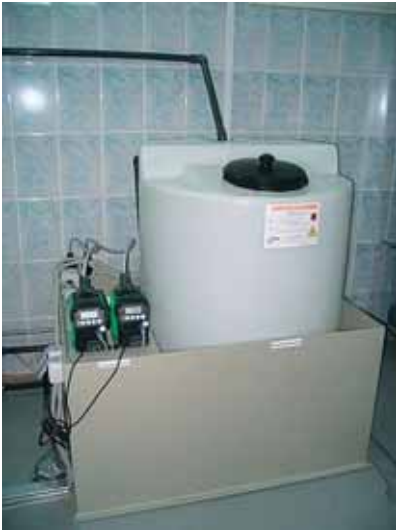
Рис. 100. Дозирование раствора гипохлорита натрия с использованием насосов DDI 209
