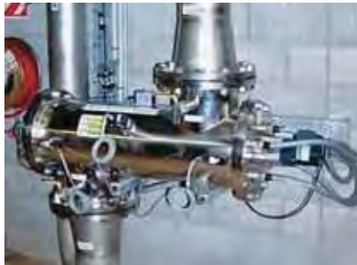
Рис. 38. Система УФ - излучения с лампами среднего давления.
